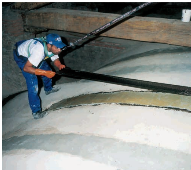
Posa in opera delle fibre di carbonio sull'estradosso della volta.
