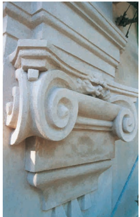
Particolare di un capitello angolare dopo l'intervento di parziale ricostruzione.
