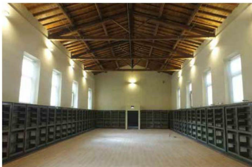
Consolidamento solaio 9. Posa nuovo pavimento.
