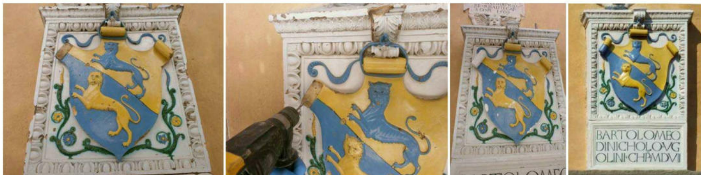
Stemma Famiglia Ugolini durante le fasi dell'intervento di stuccatura di sbreccature e scalfiture, nonché riproposte porzioni mancanti ricostruzione delle parti di ornato.
