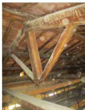
4. Le capriate presentavano fenomeni di dissesto strutturale e vistosa rotazione del monaco. 5. Dettaglio consolidamento con piastre e staffe acciaio.
