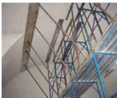
21. Puntellamento della volta lesionata. 22. Sottofondo predisposto alla stesura delle fibre carbonio volta. 23. Fase di stesura fibre carbonio volta. PAGINA SEGUENTE 24. veduta dell'avvenuto consolidamento della volta.
