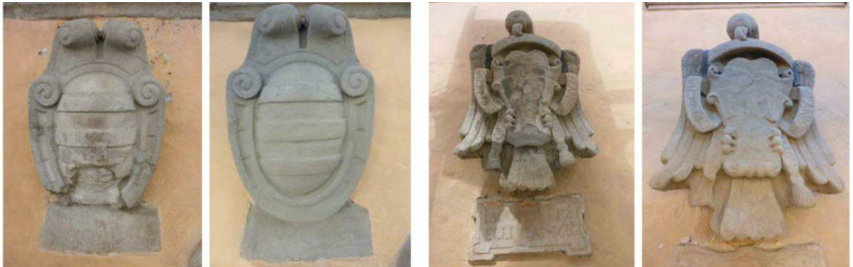
A SN_Stemma Famiglia Lotti prima e dopo l'intervento - particolarmente degradata risultava la parte inferiore, oggetto di ripresa del modellato. A DS_Stemma Famiglia Quartesi prima e dopo l'intervento - oltre alle riprese del modellato, è stato riposizionato nella parte inferiore un frammento distaccatosi.
