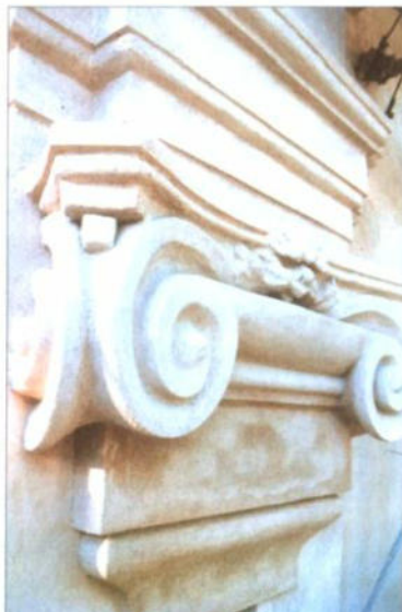
6 (sinistra). Fase di ripristino del modellato e degli elementi decorativi. 7 (destra). articolare di un capitello angolare dopo l'intervento di parziale ricostruzione.
