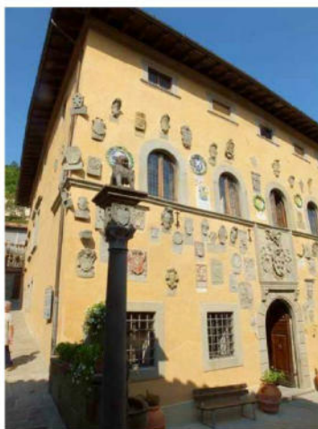
Fronte del Palazzo dopo i lavori.
