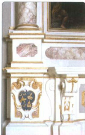
11. Dettaglio dei finti marmi restaurati e re-integrati.
